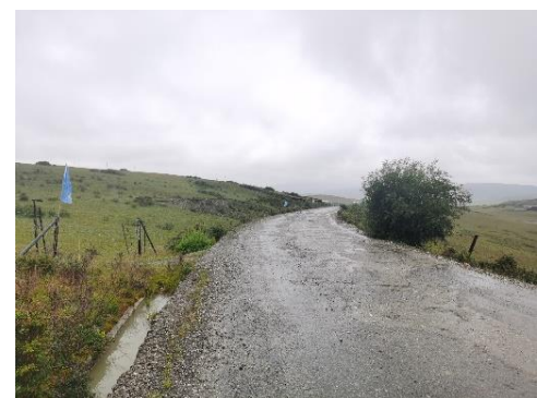
输变电工程附近村道
