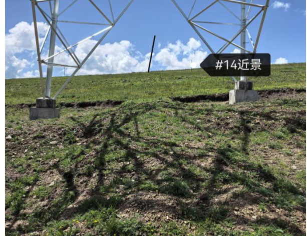
N14 号塔现状
