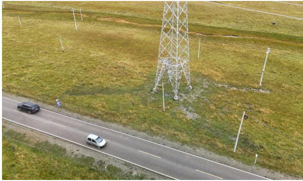
N29 号塔现状
