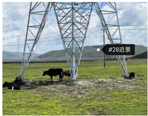
N28 号塔现状
