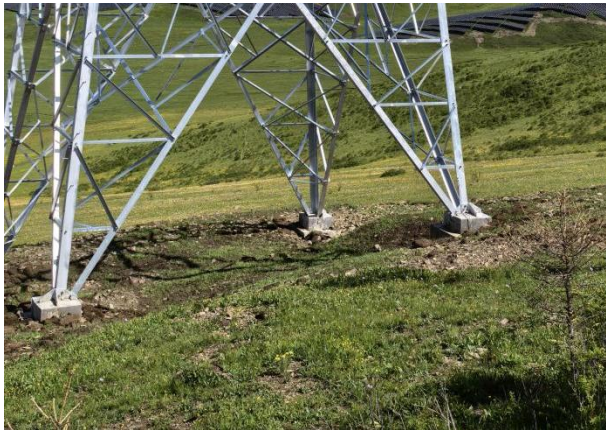
N3 号塔现状
