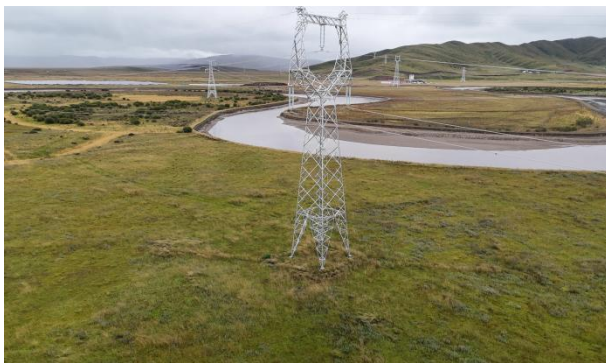
N33 号塔现状
