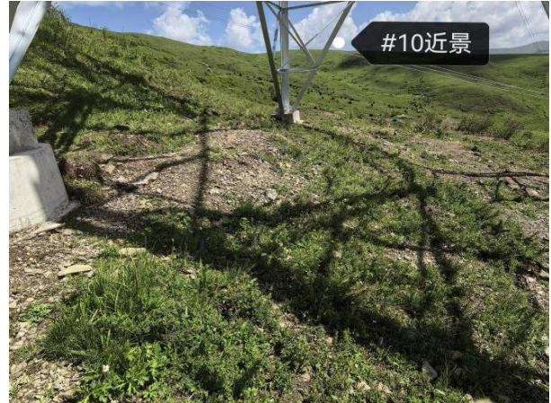
N10 号塔现状
