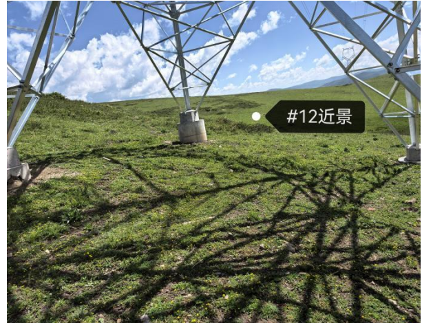
N12 号塔现状
