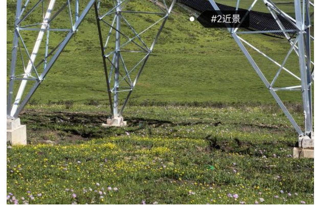
N2 号塔现状
