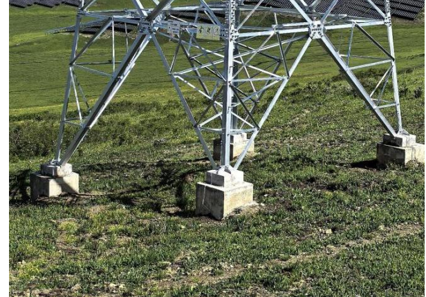
N4 号塔现状
