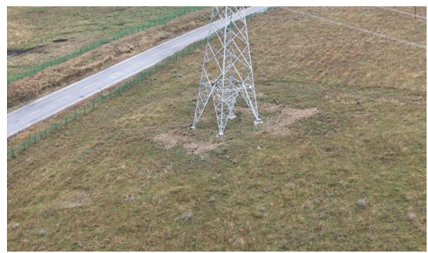
N16 号塔现状
