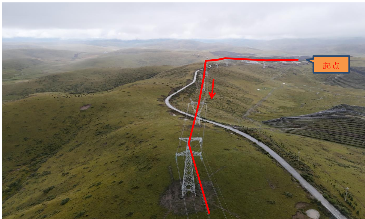
起点-N8号塔基
