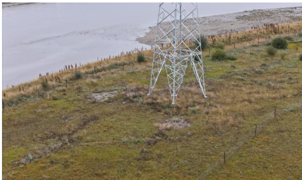
N31 号塔现状
