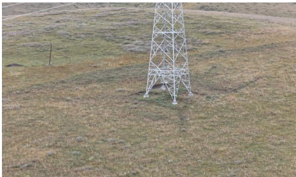
N15 号塔现状
