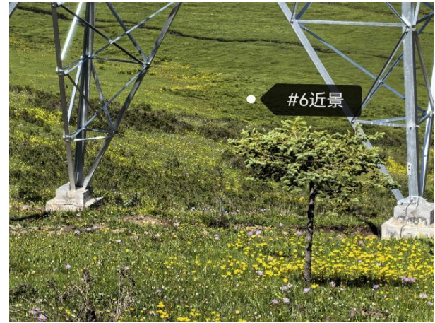
N6 号塔现状
