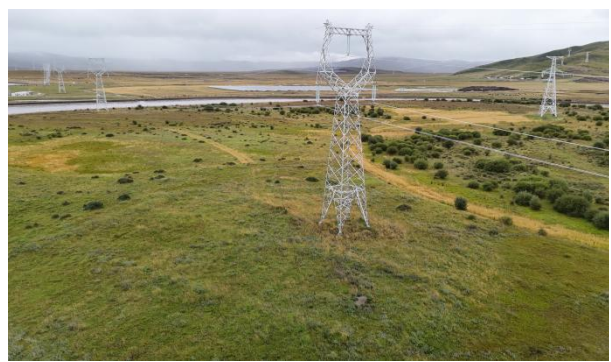
N32 号塔现状
