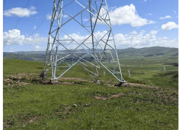
N8 号塔现状
