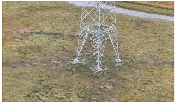
N30 号塔现状
