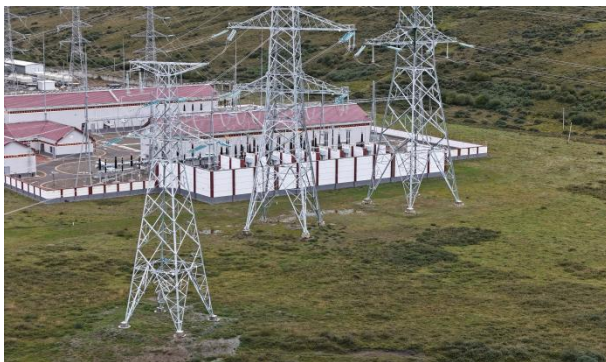
N35 号塔现状
