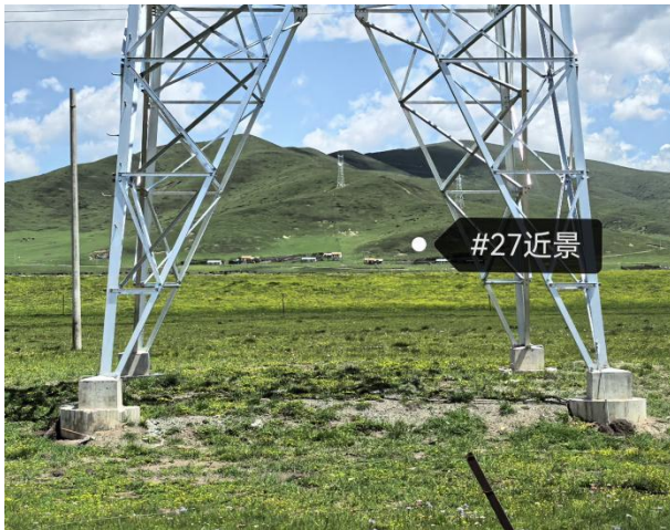
N27 号塔现状
