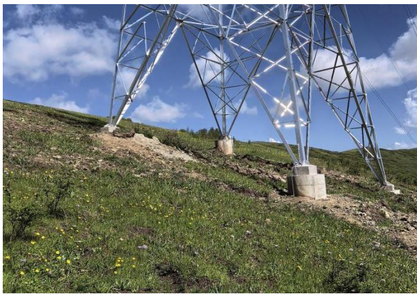
N9 号塔现状
