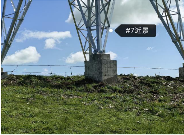
N7 号塔现状
