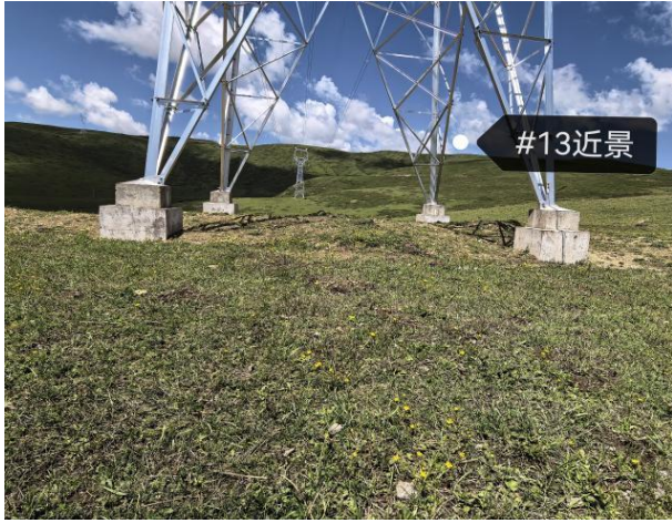
N13 号塔现状
