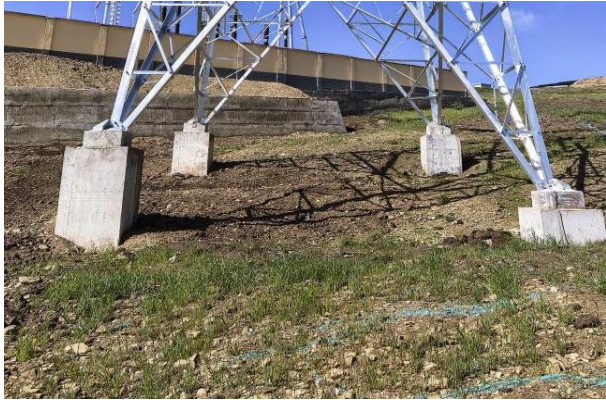
N1 号塔现状
