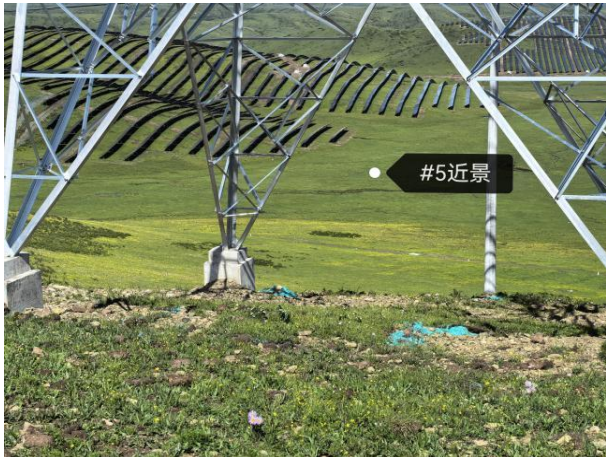
N5 号塔现状
