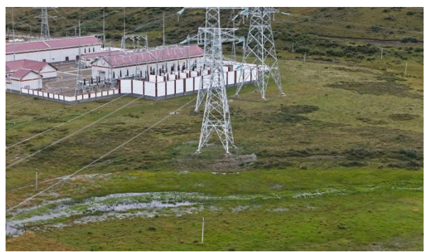
N34 号塔现状
