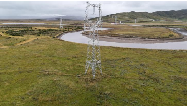
N33 号塔现状
