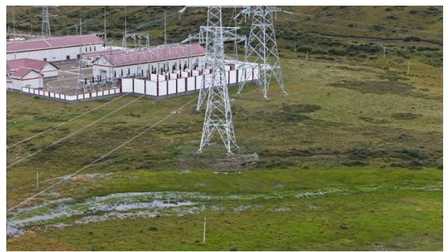
N34 号塔现状
