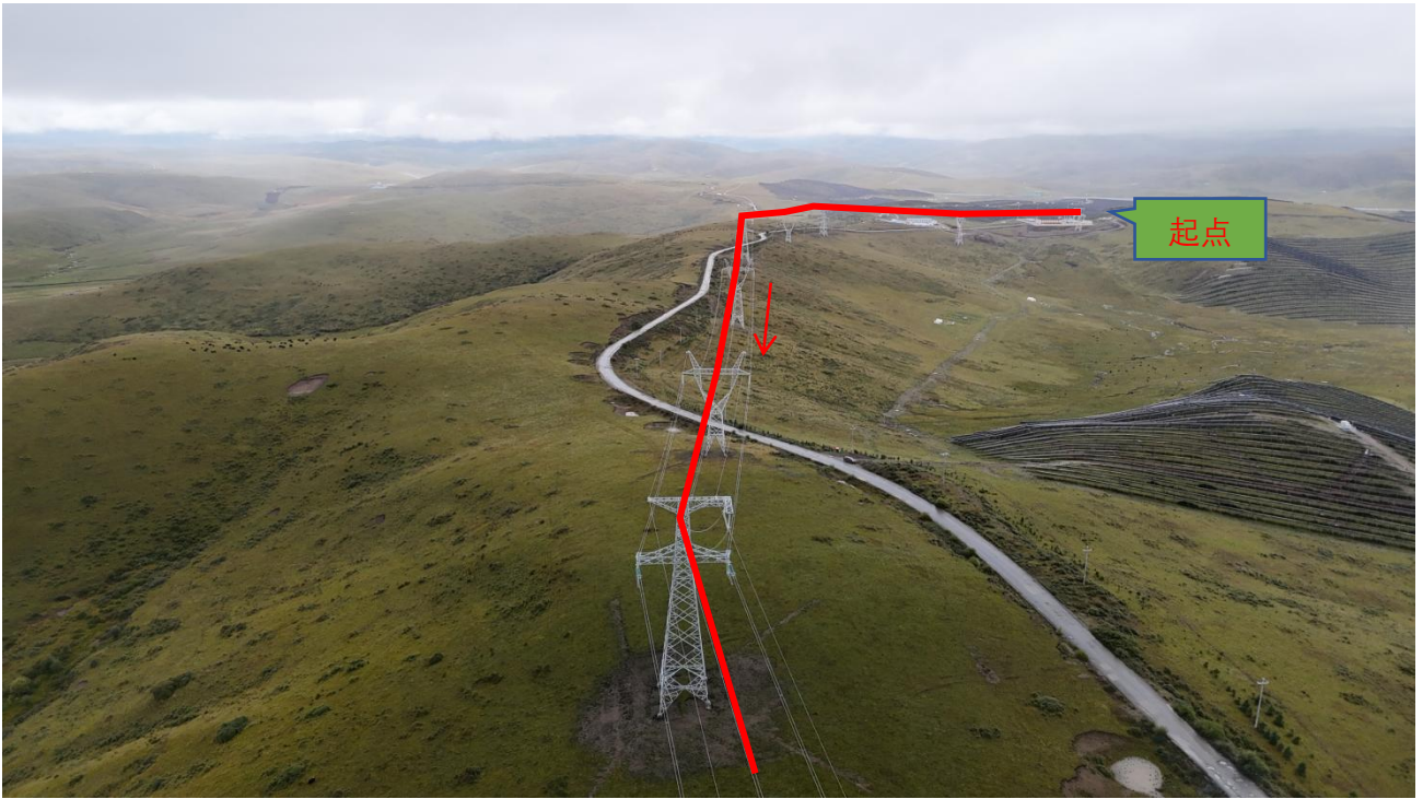
起点-N8号塔基
