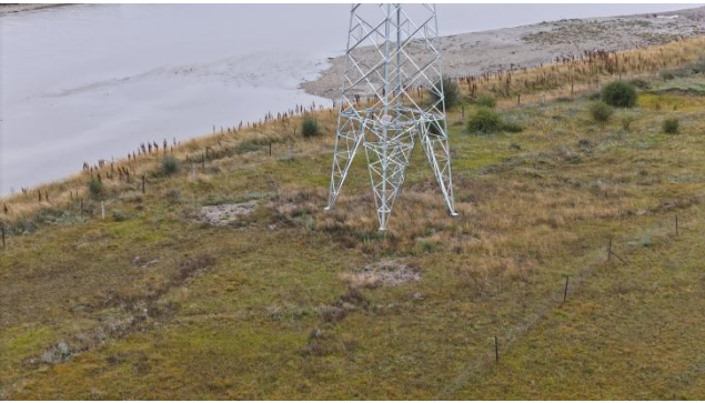
N31 号塔现状
