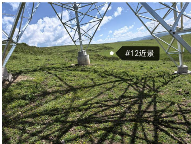
N12 号塔现状
