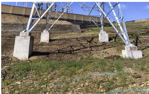
N1 号塔现状
