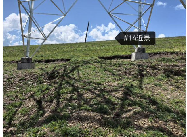
N14 号塔现状
