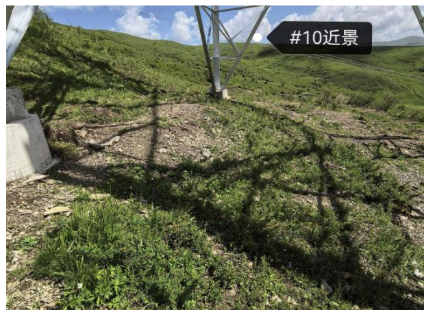
N10 号塔现状
