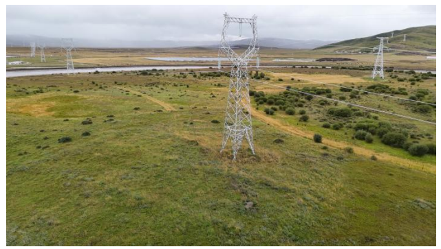
N32 号塔现状
