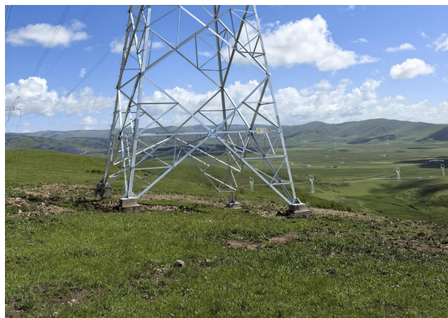
N8 号塔现状
