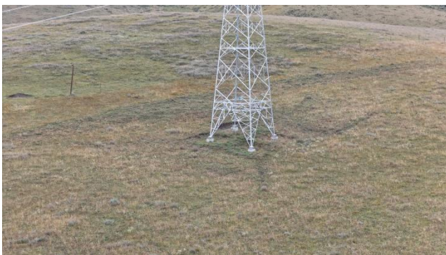
N15 号塔现状
