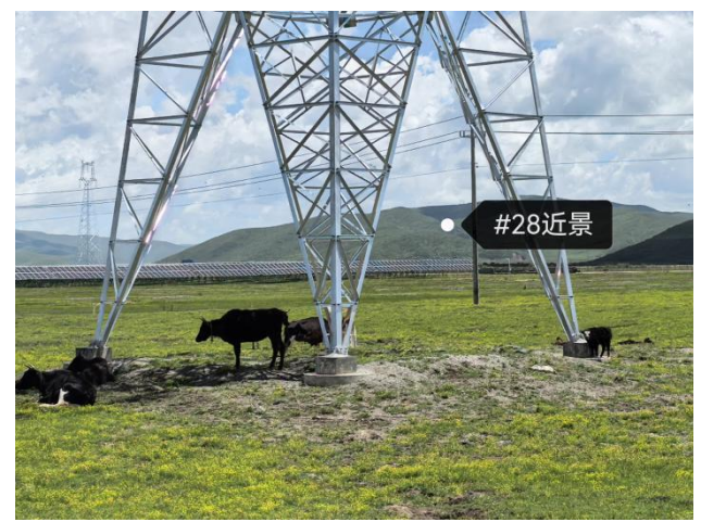
N28 号塔现状
