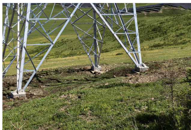
N3 号塔现状
