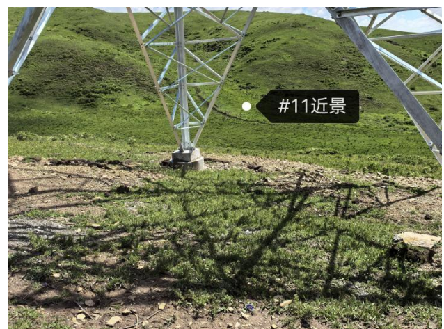
N11 号塔现状
