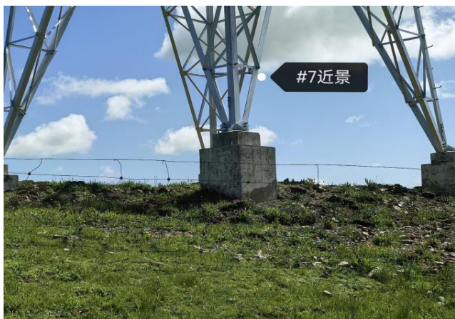
N7 号塔现状
