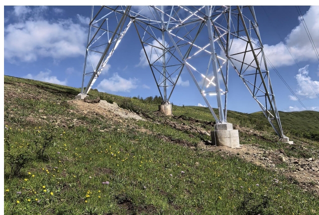
N9 号塔现状
