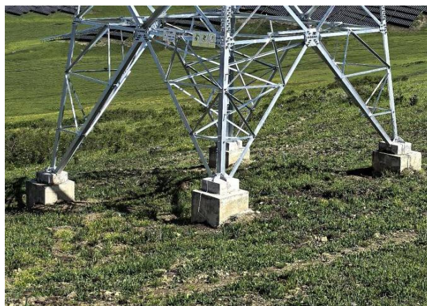
N4 号塔现状
