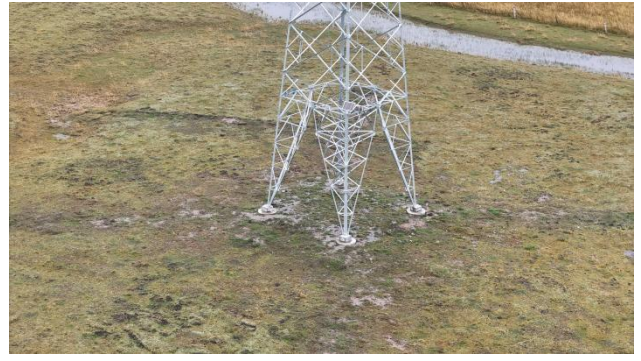
N30 号塔现状
