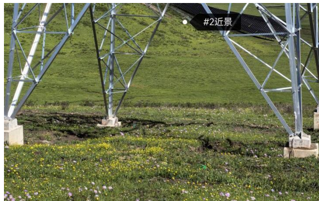
N2 号塔现状
