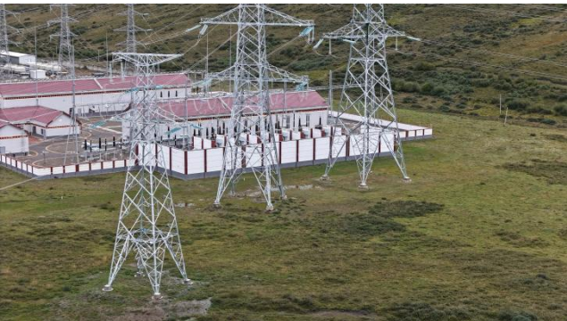
N35 号塔现状
