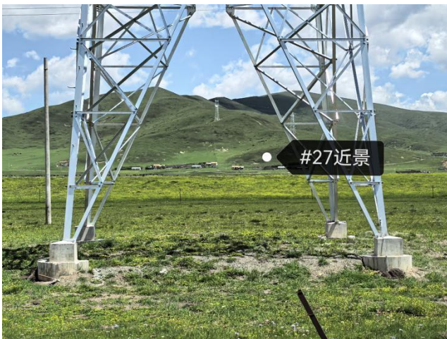
N27 号塔现状
