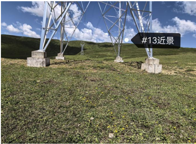
N13 号塔现状
