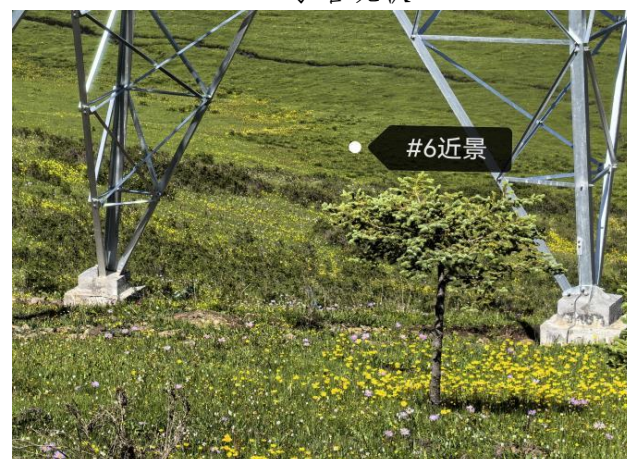
N6 号塔现状
